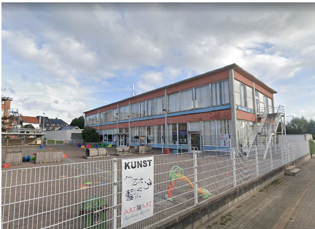
Het oud schoolgebouw langs het Stedebeekpad wordt afgebroken.
